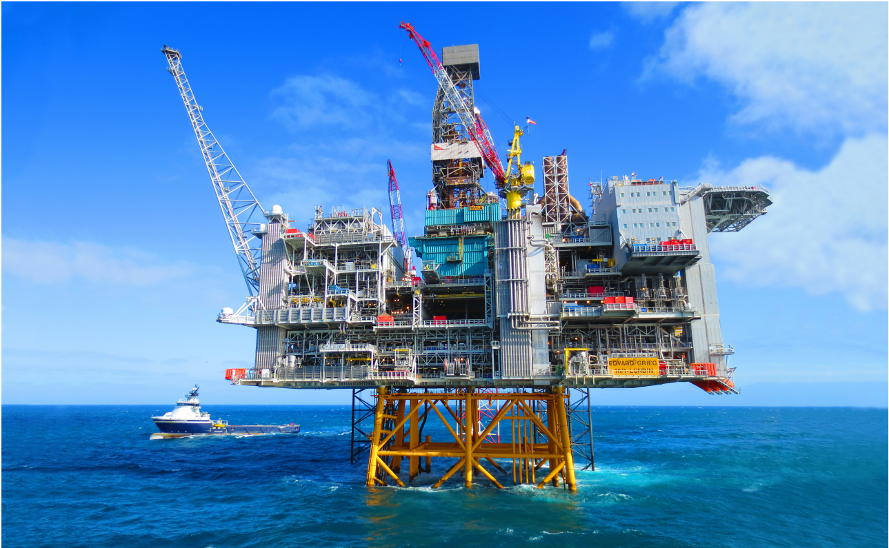
Fig. 9.1 Edvard Grieg Platform
